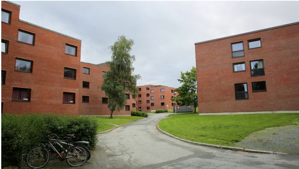
Den siste tiden har det blitt gjort en del arbeid på studentboligene på Moholt. Foto:Jahn Ivar Kjølseth
